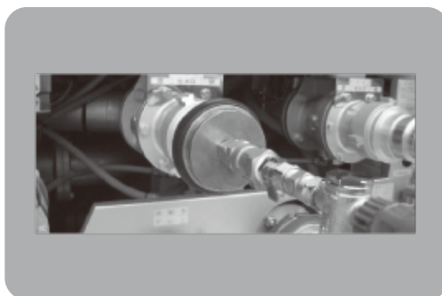
放水車接続アタッチメント
